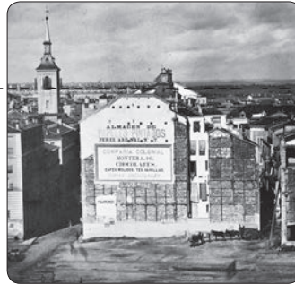
1858 Derribo de la Puerta del Sol entre las calles Arenal y Peregrinos
