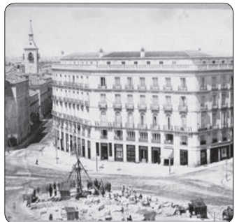
1859 Construcción de la fuente de la Puerta del Sol
