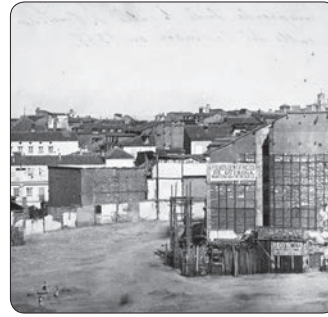
1858 Derribo desde la calle de Preciados a la del Carmen
